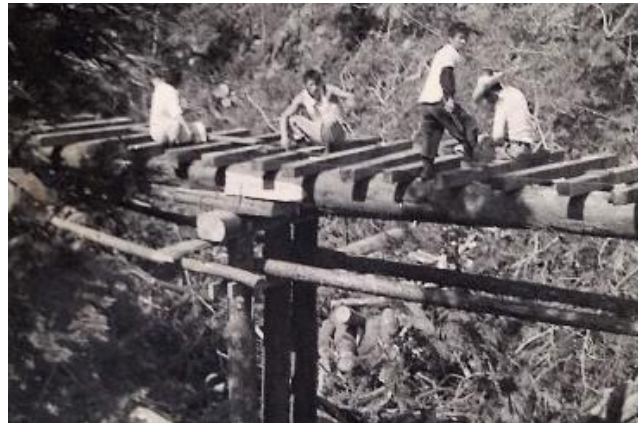
橋の上の線路敷設工事
