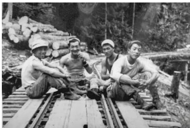
線路の敷設工事
