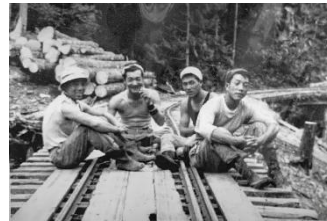
線路の敷設工事
