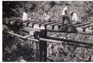
橋の上の線路敷設工事
