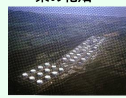
国家石油備蓄基地
